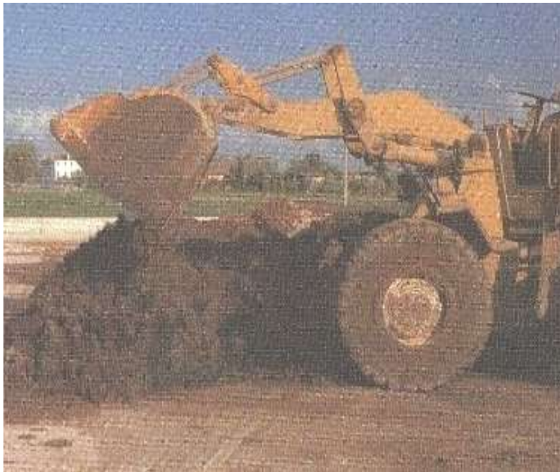
Utilizzo della pala meccanica per la formazione del cumulo
